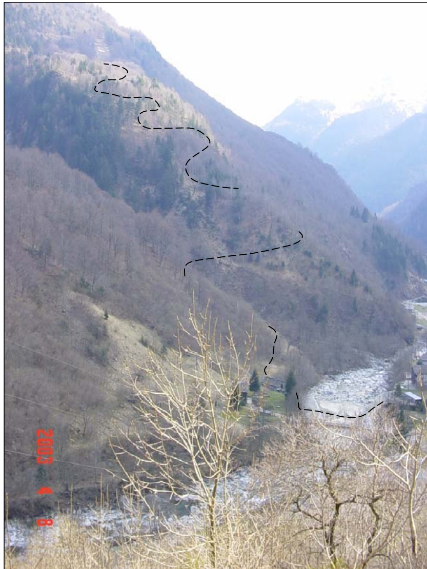
Foto 1 - Panoramica generale dell'area di intervento
