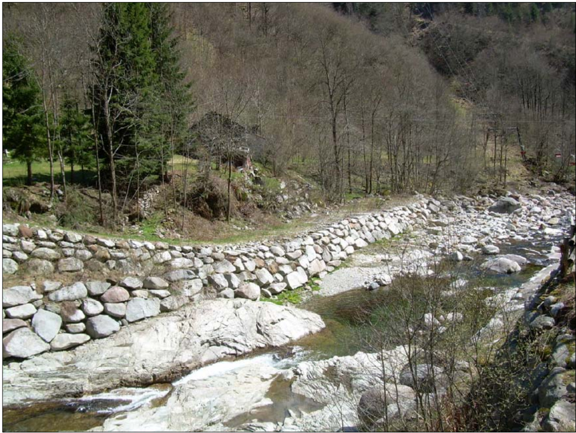
Foto 18 - Zona di attraversamento del Torrente Egua, vista da monte verso sponda sinistra
