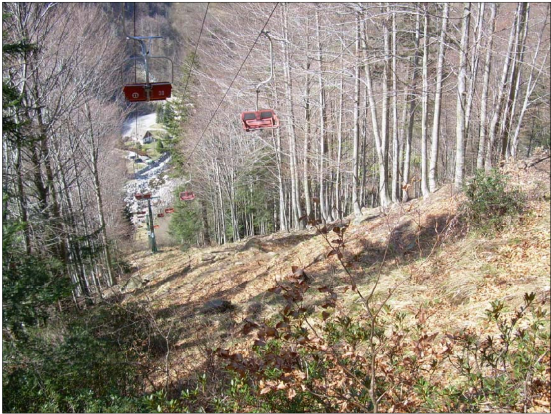
Foto 10 - Primo e secondo attraversamento seggiovia (da sez. 8 a sez. 10)
