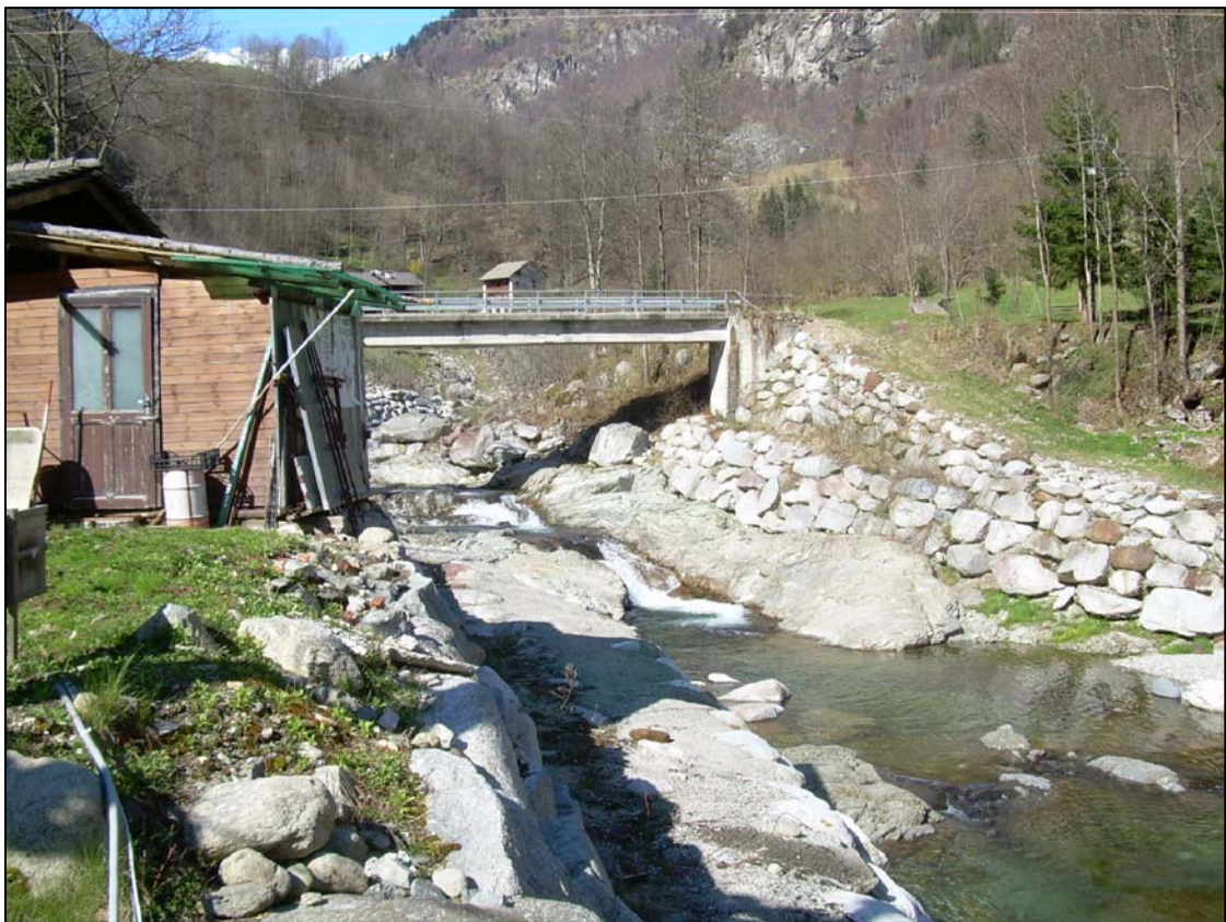
Foto 19 - Zona di attraversamento del T.Egua, vista da monte e stazione di arrivo in sponda destra
