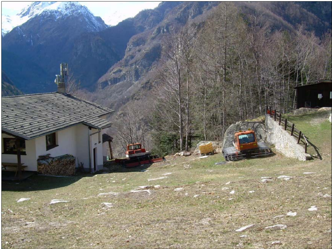
Foto 3 - Zona presso sez. 2
