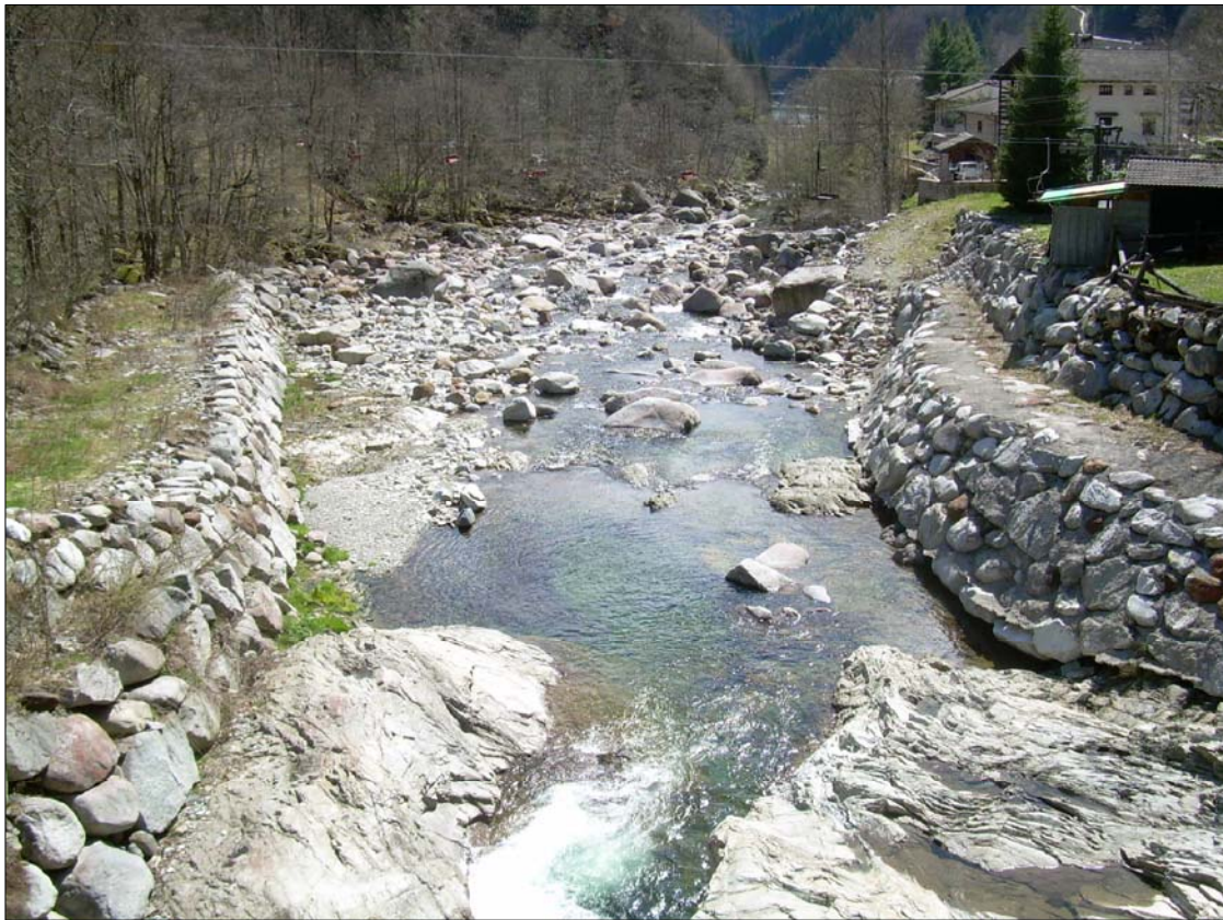
Foto 20 - Zona di attraversamento del T.Egua, vista da valle e stazione di arrivo in sponda destra
