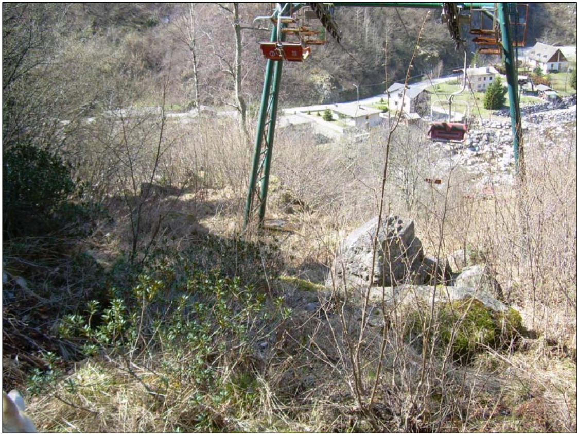
Foto 15 - Quinto attraversamento seggiovia (sez. 26)
