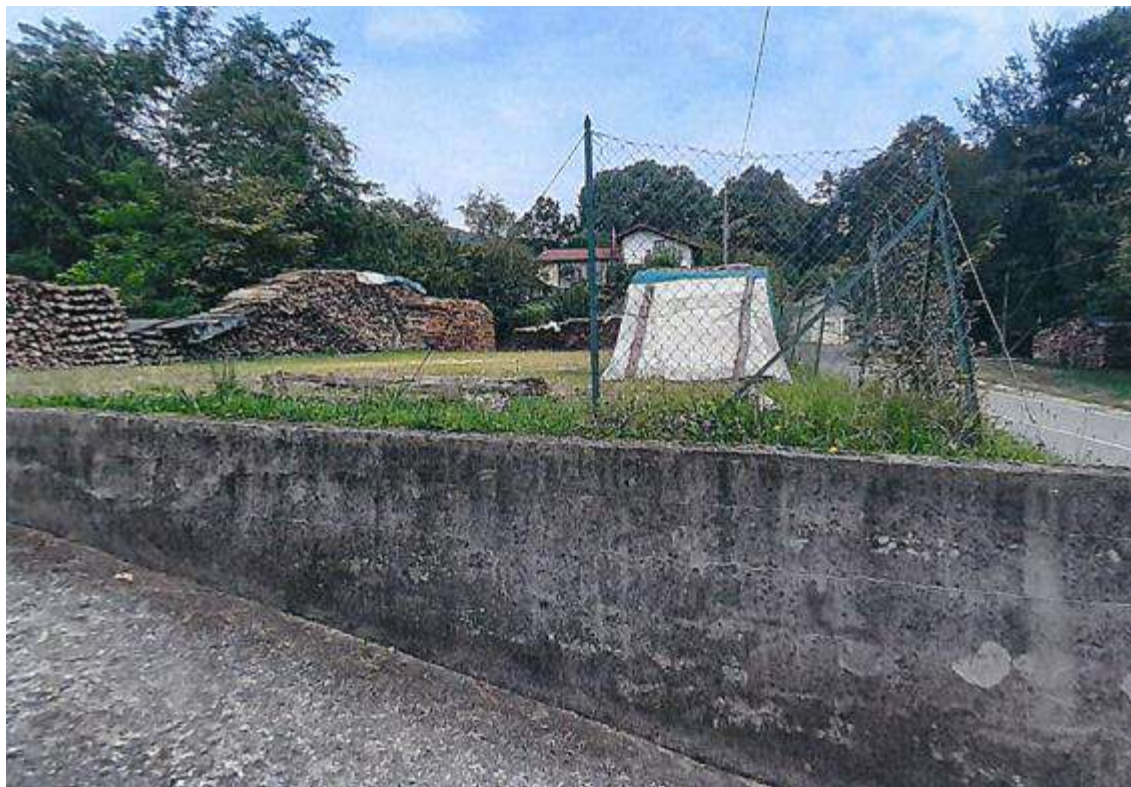
VISTA FOTOGRAFICA, DALLA VIABILITA', DETTAGLIO
