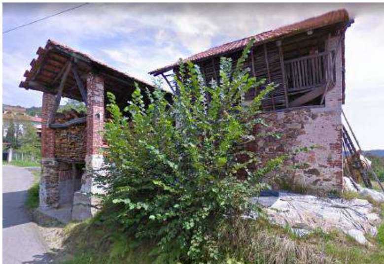
Edifici rurale e fienili a sud di Sella
