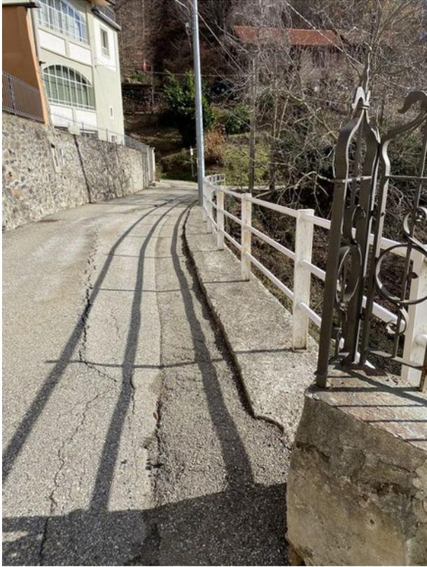
**FOTO 16 - FRANA FA10 21\_35 – Ribassamento del piano viabile, ma in adiacenza a trincea di scavo ripristinata**
