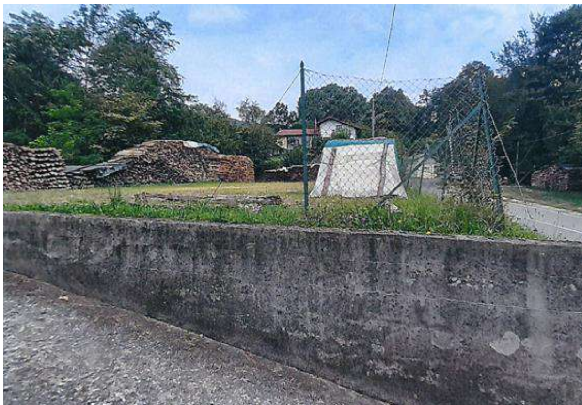
VISTA FOTOGRAFICA, DALLA VIABILITA', DETTAGLIO
