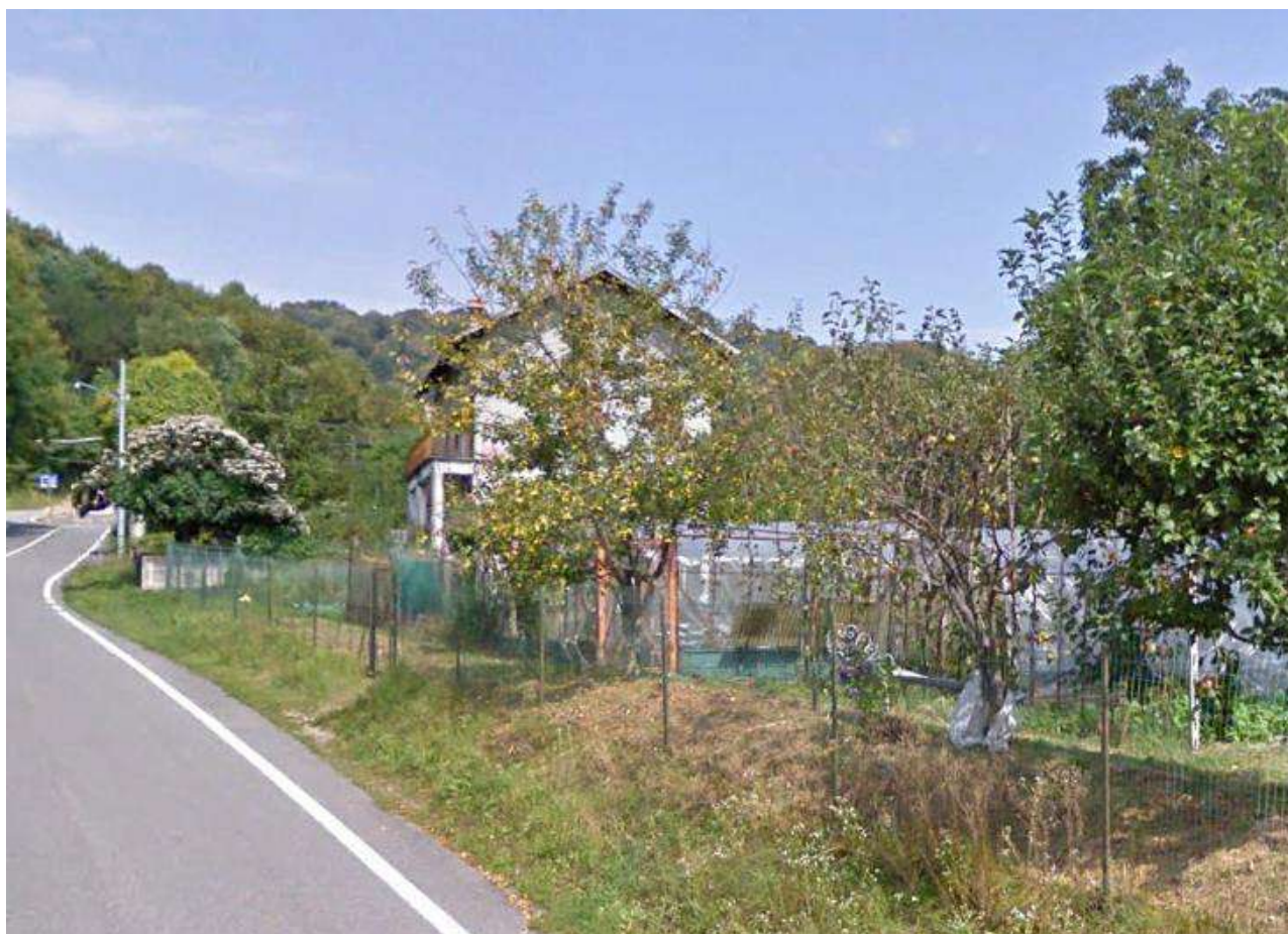
VISTA FOTOGRAFICA DA SUD DALLA PROVINCIALE
