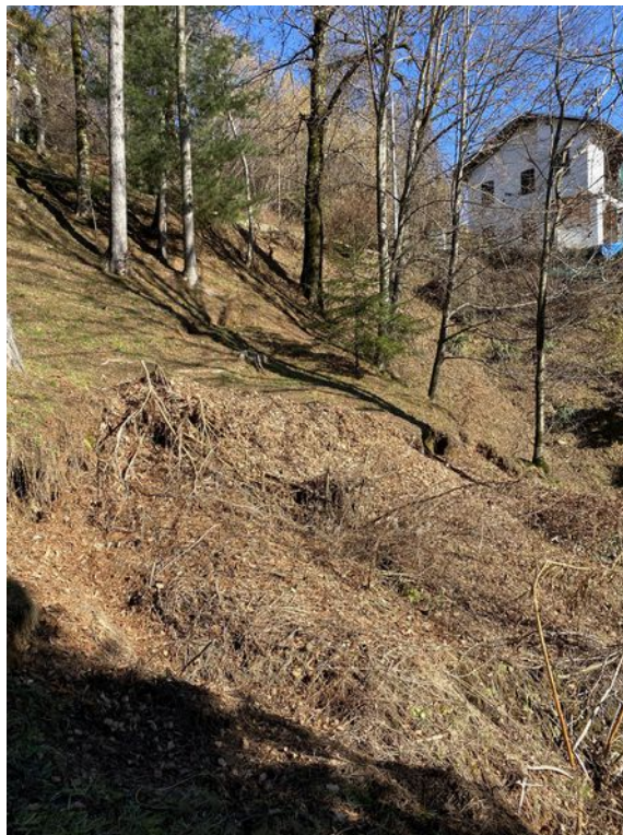
FOTO 1 - FRANA FA10 21_18 – Coronamento frana e posizione abitato
