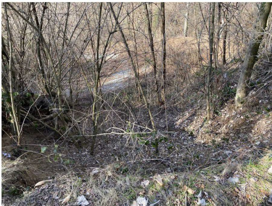
FOTO 4 - FRANA FA10 21_19 – Ripresa della frana dall'alto, sullo sfondo il tracciato stradale
