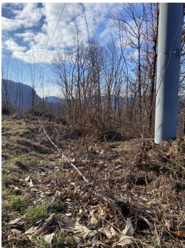
FOTO 5 - FRANA FA10 21_20 – Dettaglio del sostegno della linea elettrica interessata dal ribassamento
