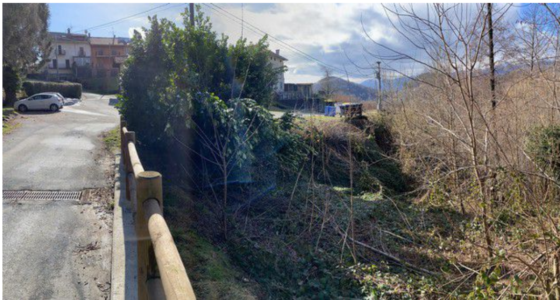
FOTO 18 - FRANA FA3 21_34 – Area ecologica minacciata dall'evoluzione della frana
