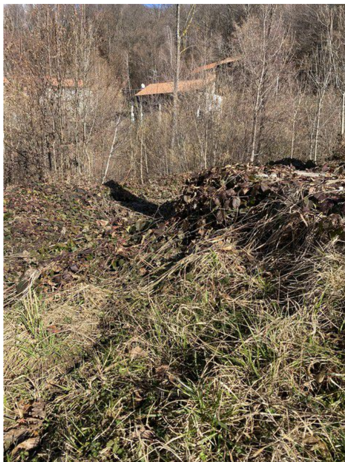
FOTO 19 - FRANA FA3 21_34 – Ribassamento della superficie del suolo lungo pendio posto a valle dell'area ecologica
